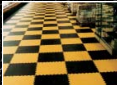
Nach der Verlegung
