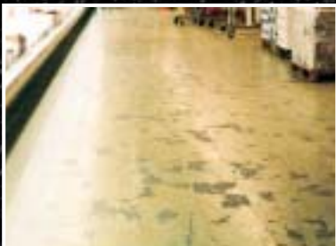
Vor der Verlegung
